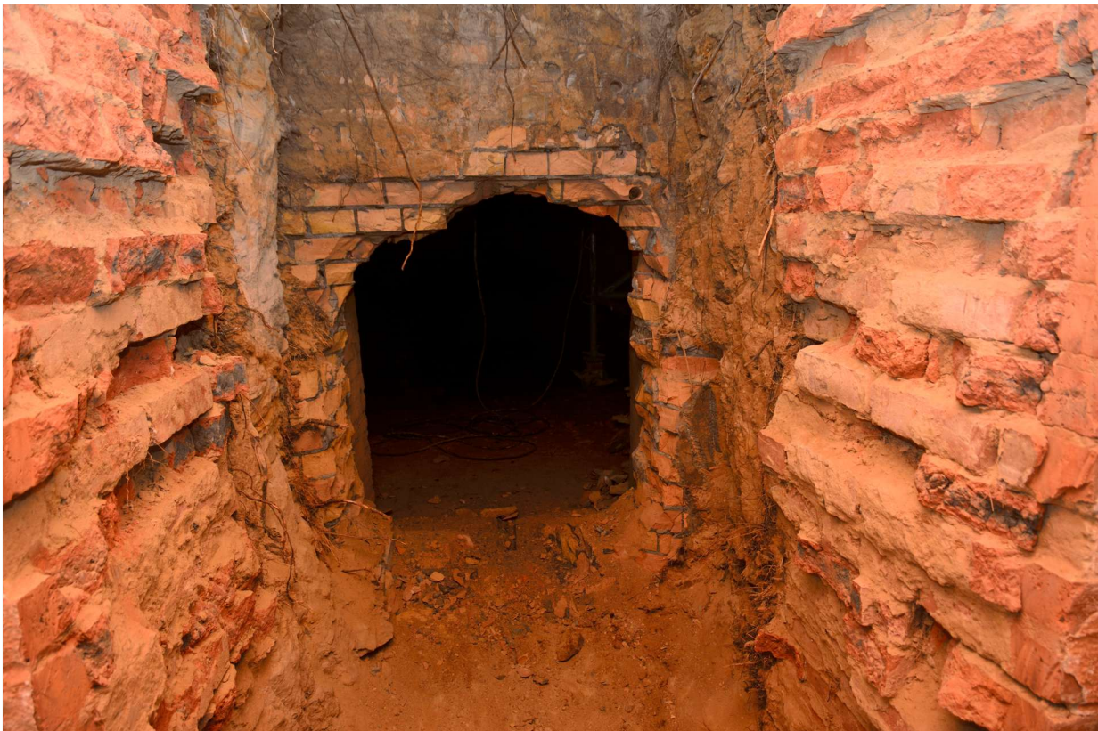
Abbildung 1: Durchbruch vom Schieberhaus zum Wasserbehälter im Jahr 2017
